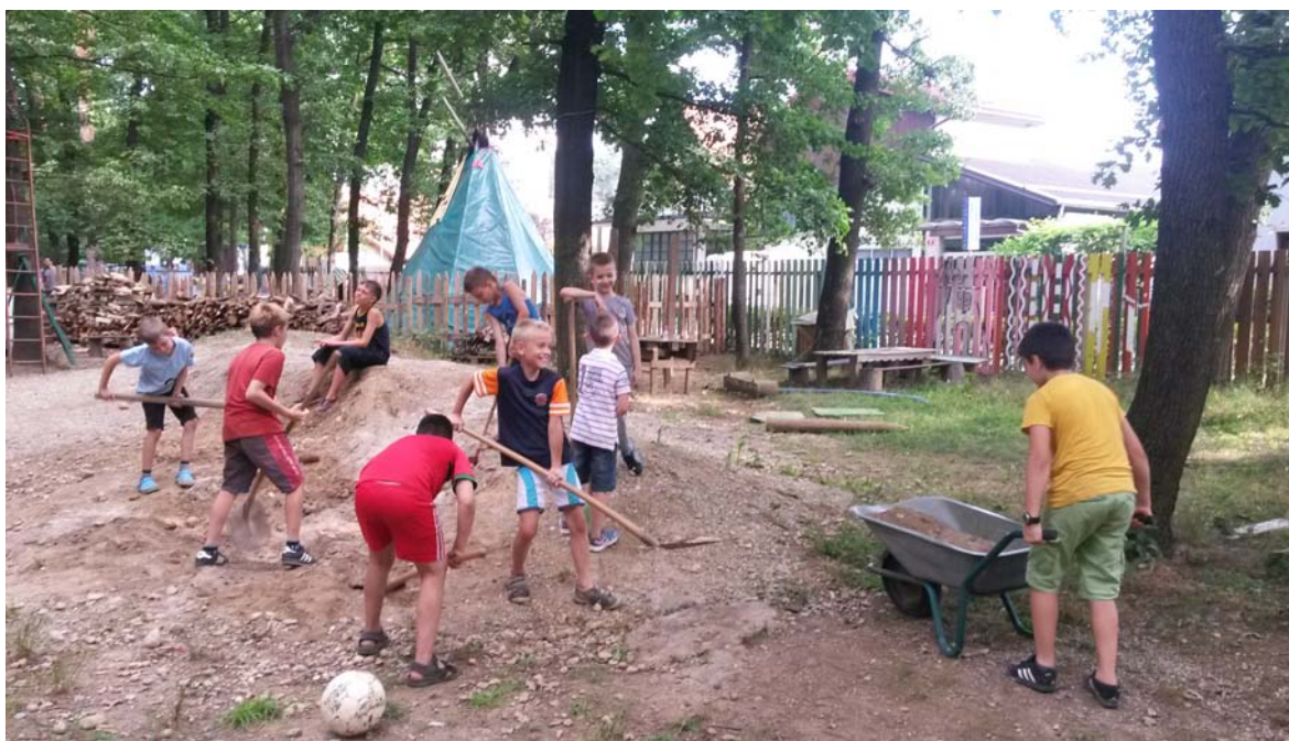
Slika 8: Del Doživljajskega igrišča, gradbišče
